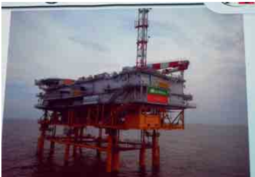
Jacket, un dispositivo de cimentación para la eólica marina.
